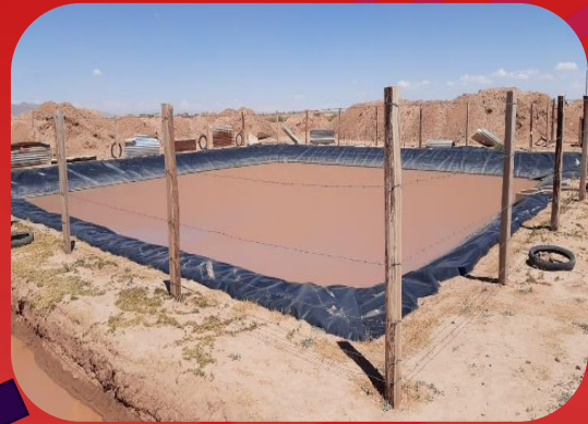
VIGIÑAS CON IMPERMEABILIZANTE
